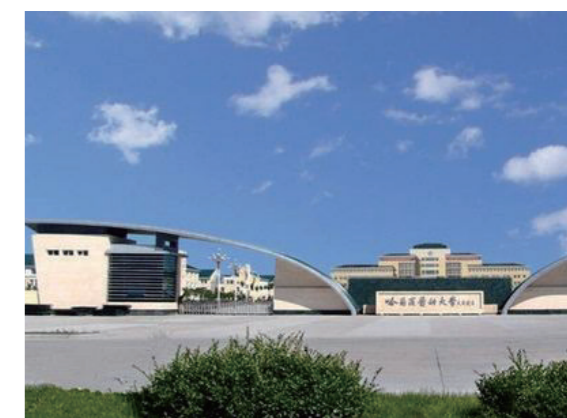
哈尔滨医科大学大庆分校实验室净化通风工程项目
