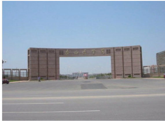
泰山医学院化工学院基础化学实验室通风工程
