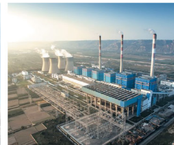
中核甘肃矿区电厂
