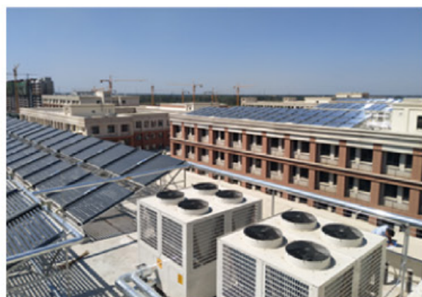
商河县西城区高级中学“太阳能”+空气源热泵热水系统
