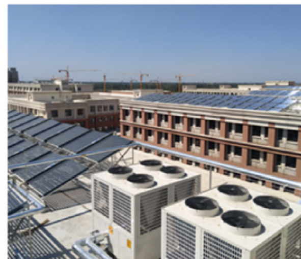
商河县西城区高级中学“太阳能”+空气源热泵热水系统
