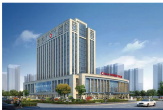
梁山县人民医院机房改造项目
