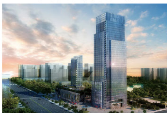
院新文化创新广场机房项目
