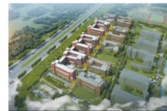
河北大学综合实验楼
