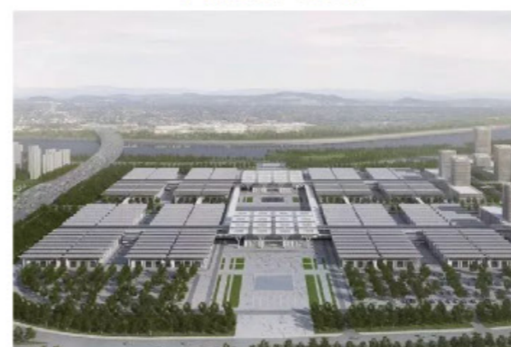
天津国际会展中心项目（东区）
