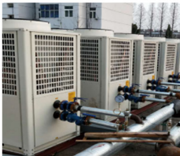
徐州小区改造项目
