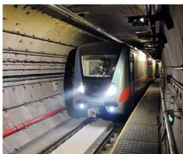
天津地铁5号线
