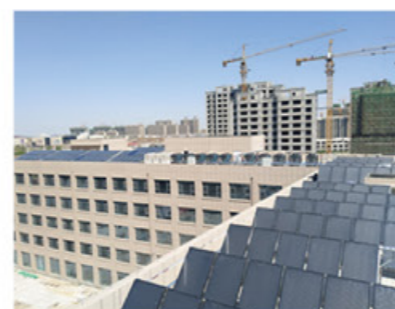
商河县西城区高级中学“太阳能”+空气源热泵热水系统
