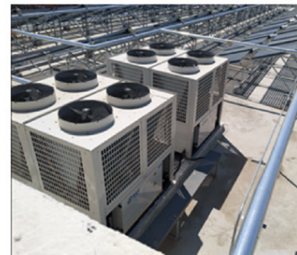
商河县西城区高级中学“太阳能”+空气源热泵热水系统
