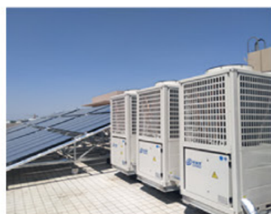
商河县西城区高级中学“太阳能”+空气源热泵热水系统
