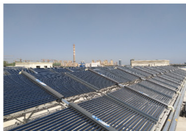
商河县西城区高级中学“太阳能”+空气源热泵热水系统
