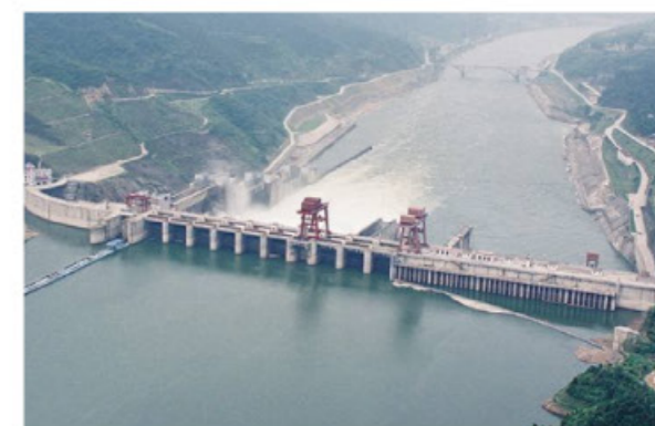
湖南怀化五强溪水电厂
